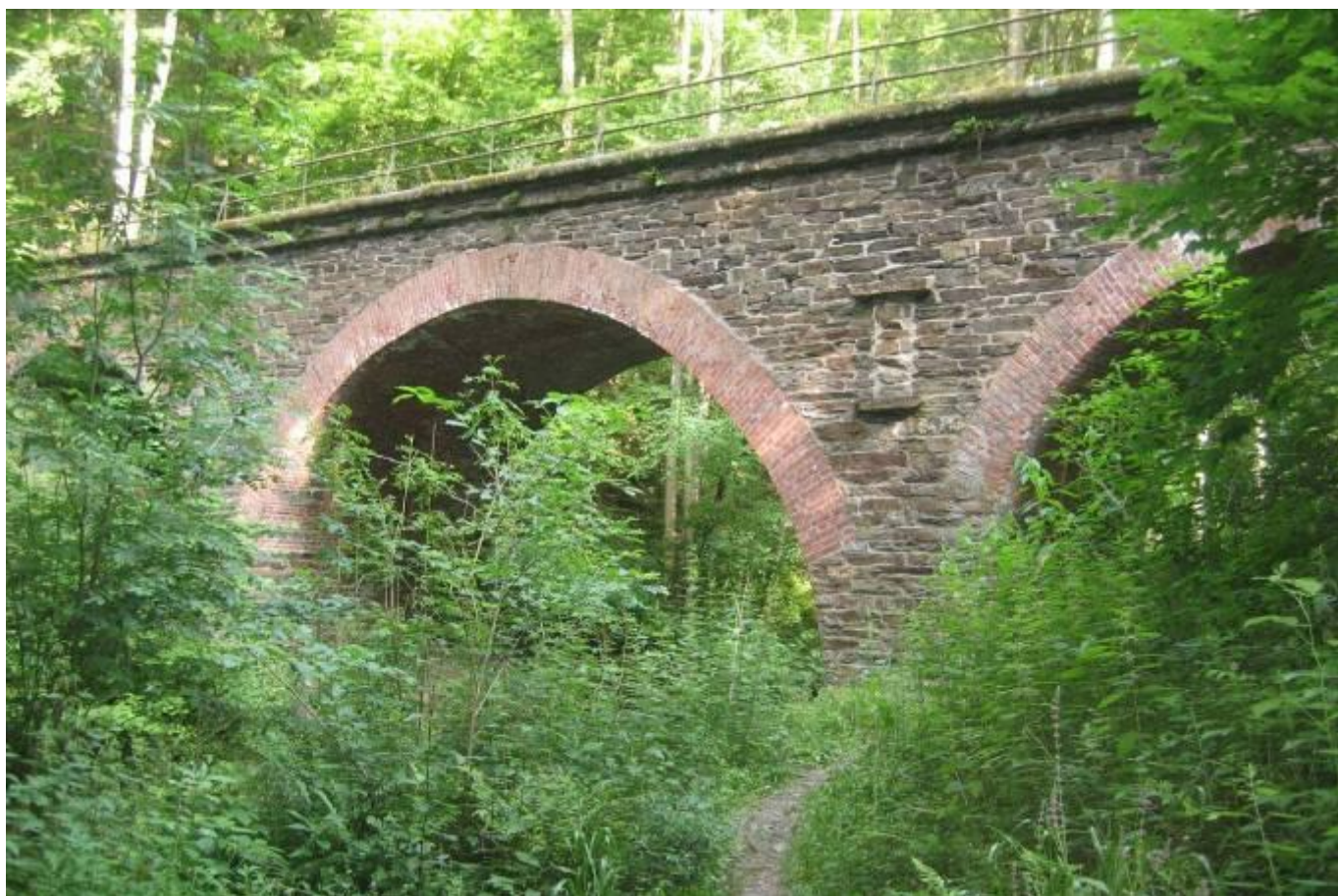
...und mit mehreren Viadukten.
