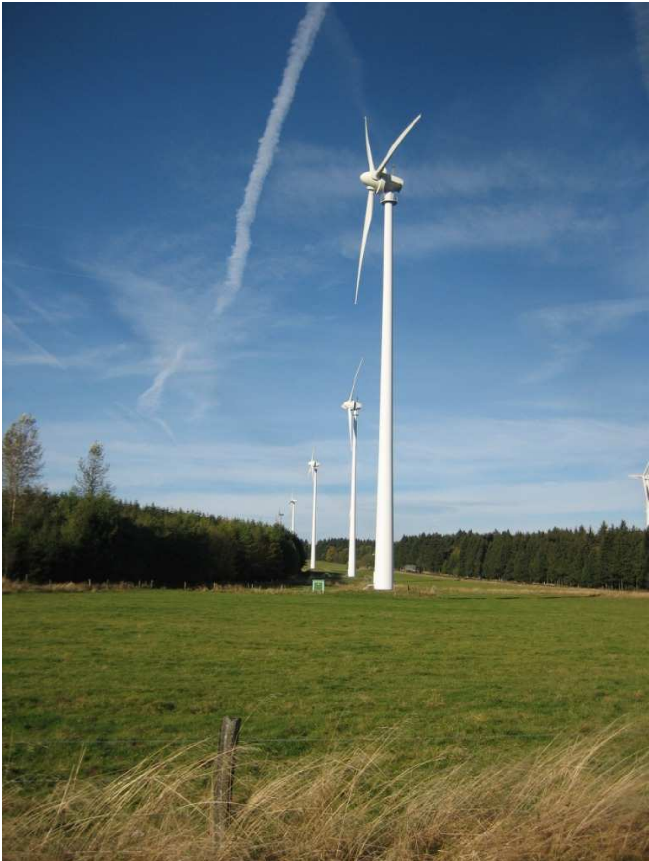
Die Windräder bei Heisterberg sind teilweise in einer Linie parallel zur Hauptwindrichtung (in diesem Gebiet von West nach Ost) angeordnet.
